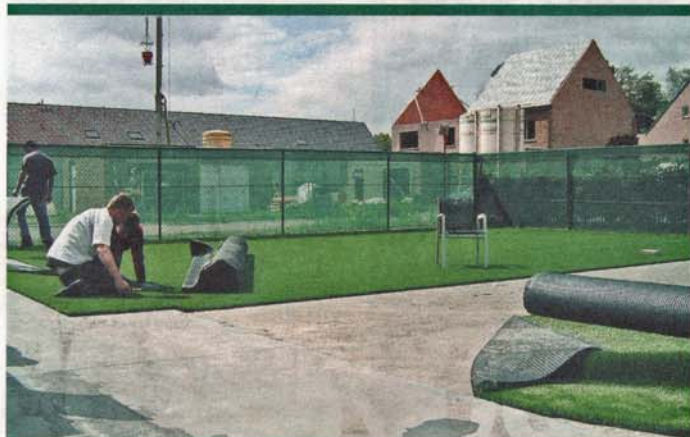
Bij het leggen van kunstgras is de voorbereiding van de ondergrond zeer belangrijk.
